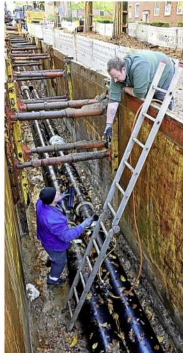
Viktor Niss (l.) und Jan Schulte-Frankenfeld bereiten eine Röntgenkontrolle einer Schweißnaht der Fernwärmeleitung am Langen Peter vor.
